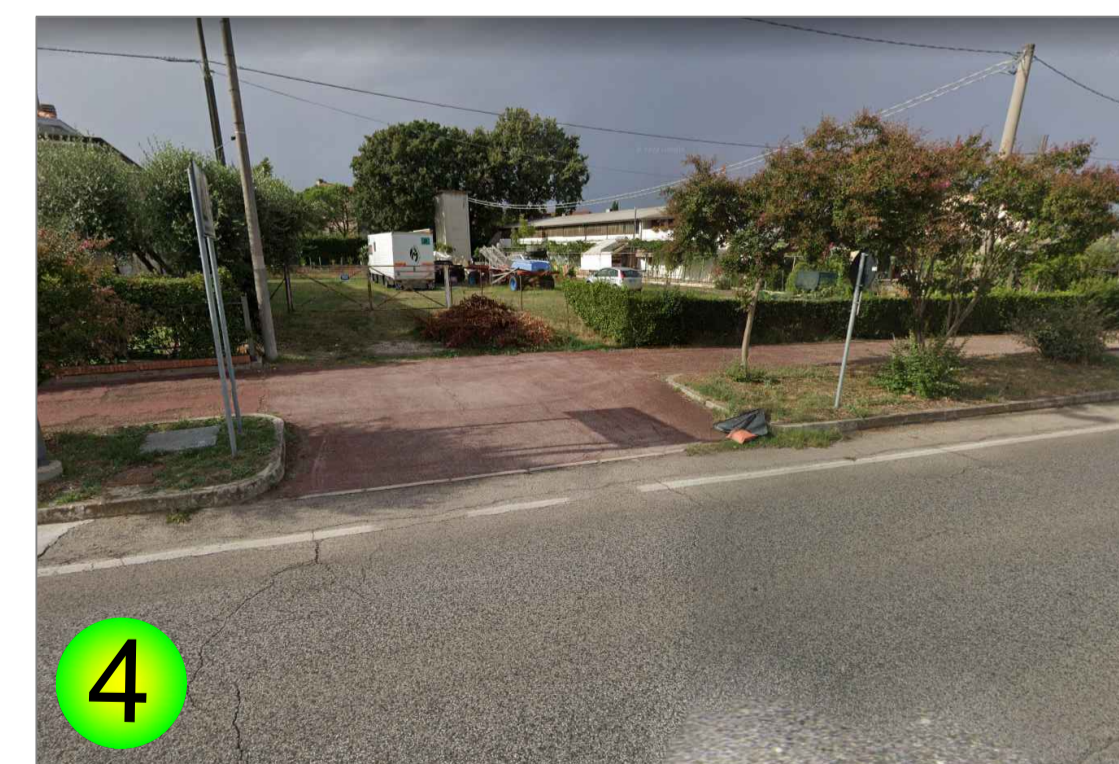
4 PARTE PERCORSO CICLOPEDONALE ESISTENTE CON PAVIMENTAZIONE
