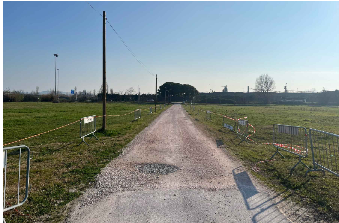
2_Vista dalla strada bianca esistente in direzione della via Emilia
