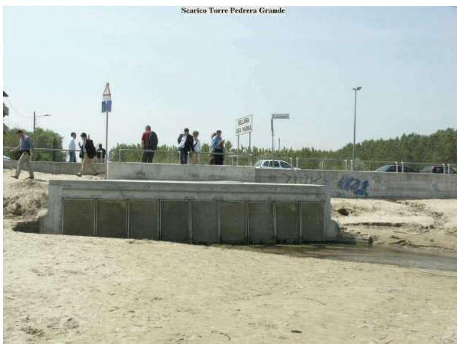
**Figura 7.2.1.3 – Scarico della fossa Pedrera Grande. Sono visibili le ventole che trattengono i solidi grossolani.**
