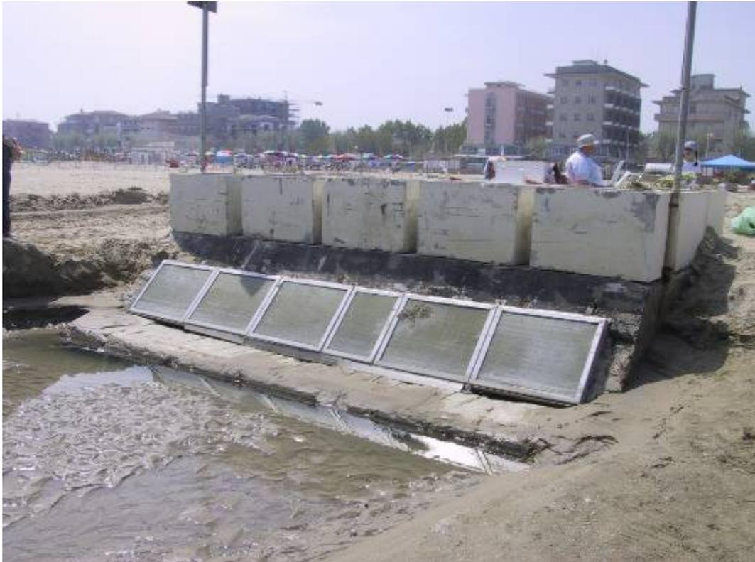
**Figura 4.1.1– Ventole in vetroresina e metallo in corrispondenza dello sbocco delle fosse consortili**
