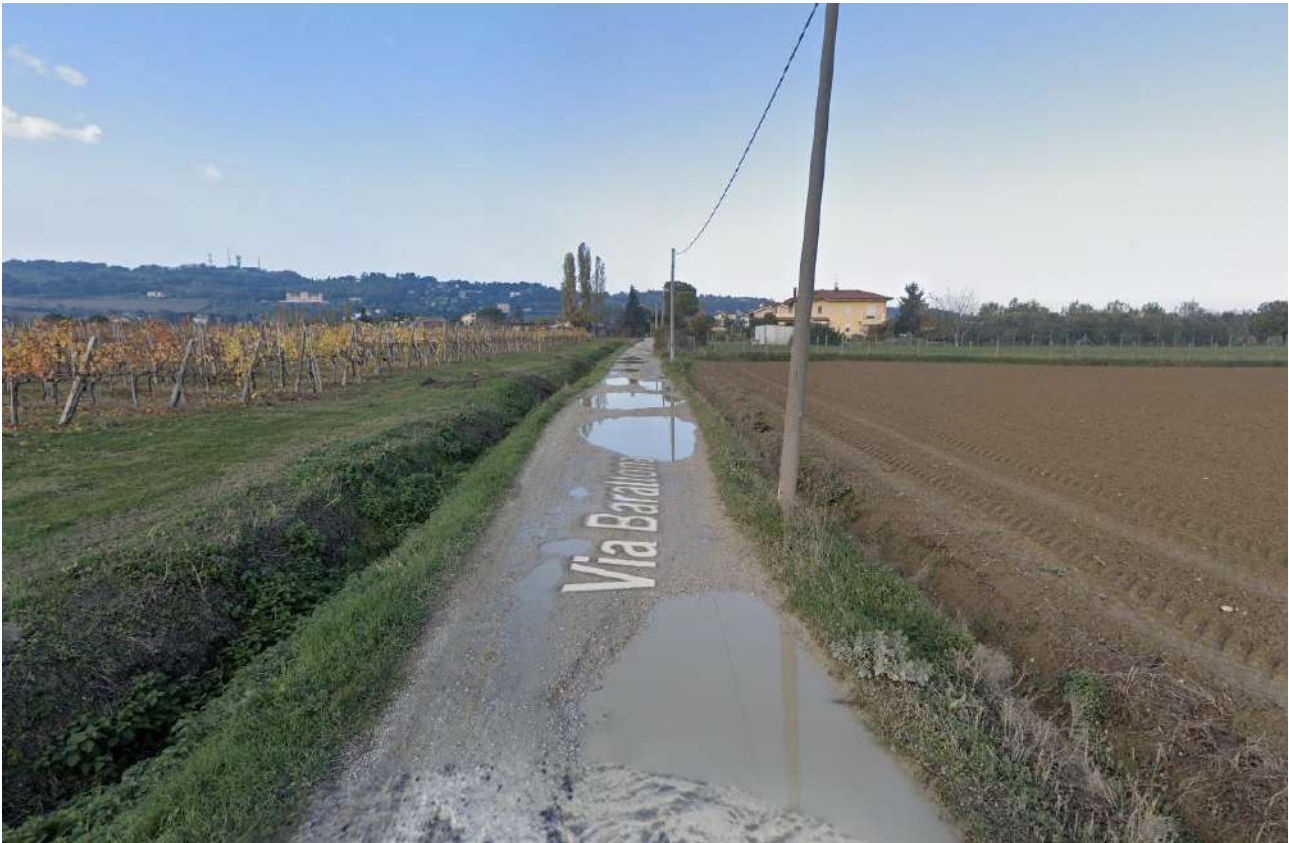
Figura 128 – Precarie condizioni e sostanziale inadeguatezza di Via Barattona al transito di mezzi pesanti.
