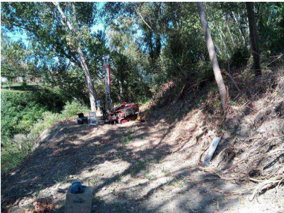
Figura 26 – Prova penetrometrica con piezocono CPTU 2.1 eseguita in destra idrografica.
