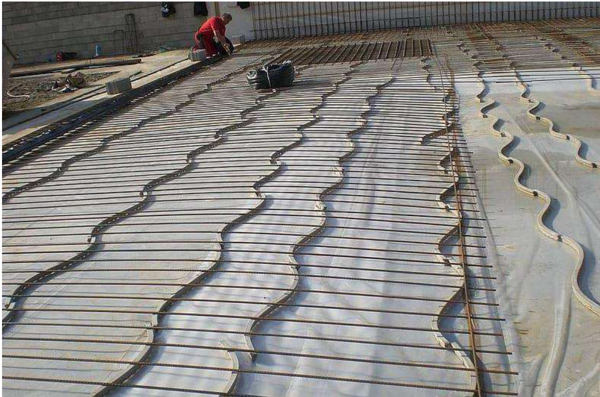
Figura 97 – Distanziatori in fibrocemento per armature orizzontali (fonte: Max Frank Italy S.r.l. - www.maxfrank.com ).
