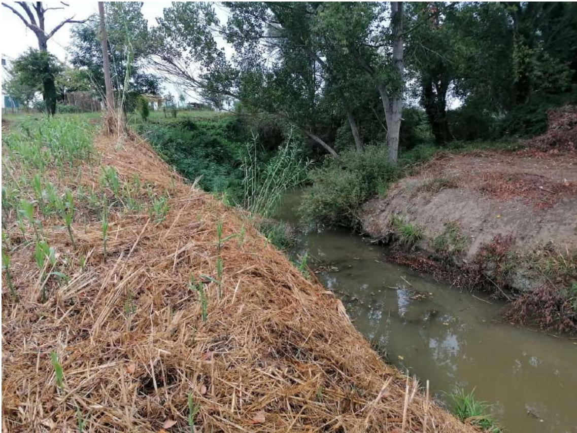
Figura 11 – Alveo del torrente Ausa. Foto scattata dalla sponda in sinistra idraulica.
