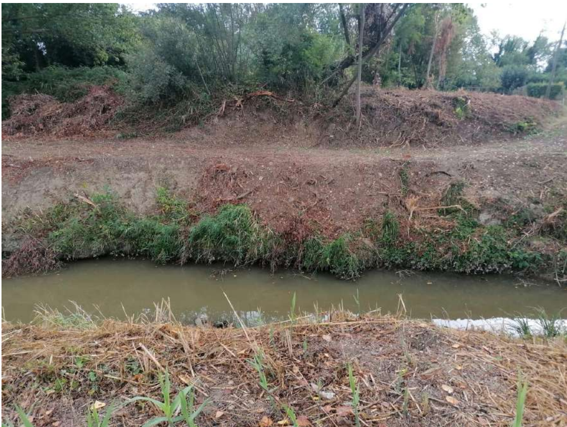
Figura 12 – Alveo del torrente Ausa. Foto scattata dalla sponda in sinistra idraulica.
