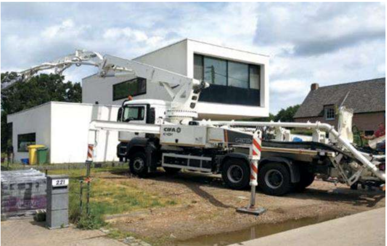
Figura 135 – Pompe autocarrate per getti di calcestruzzo.
