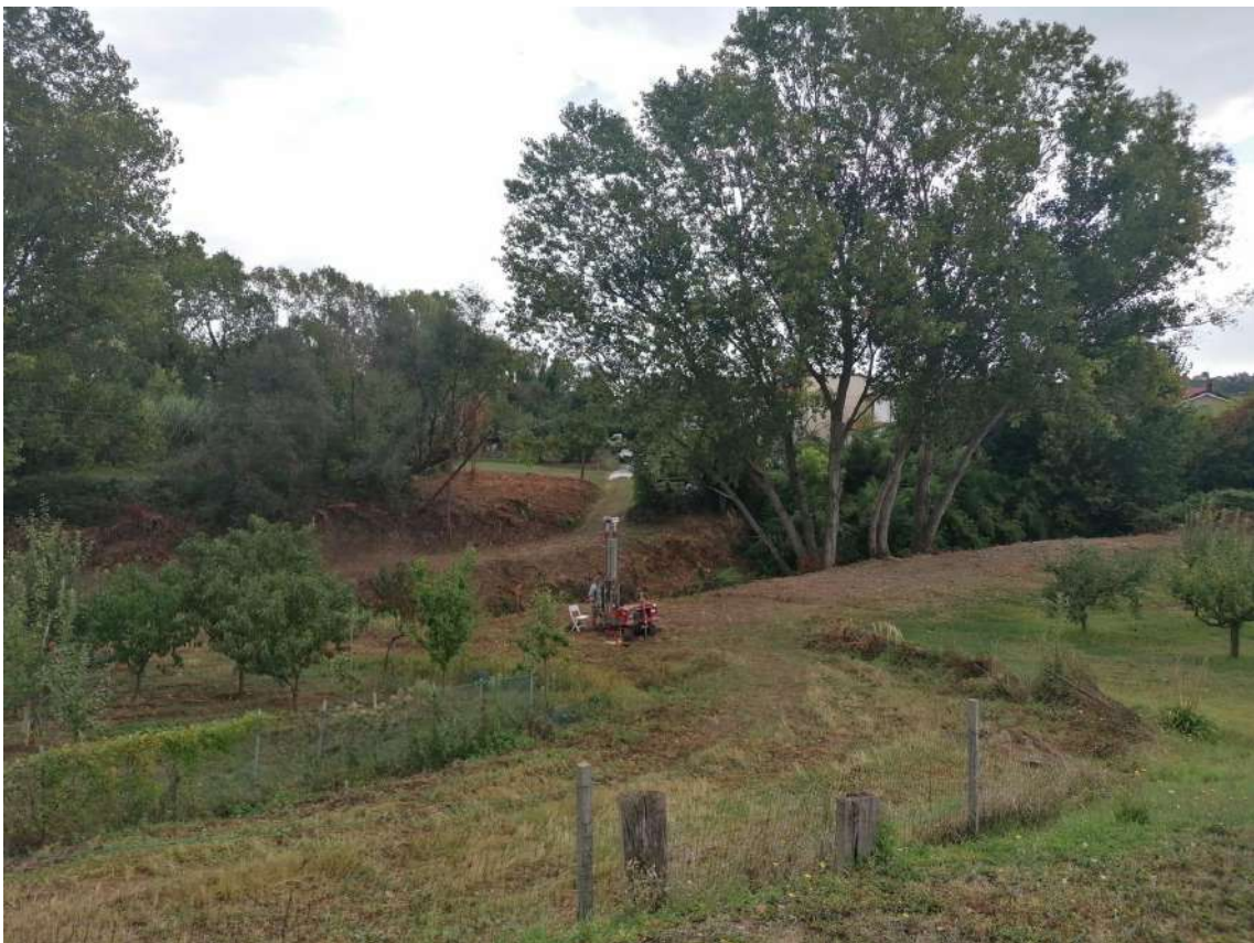
Figura 4 – Vista dell'area interessata dalla costruzione della passerella in progetto, lato sponda sinistra idrografica.
