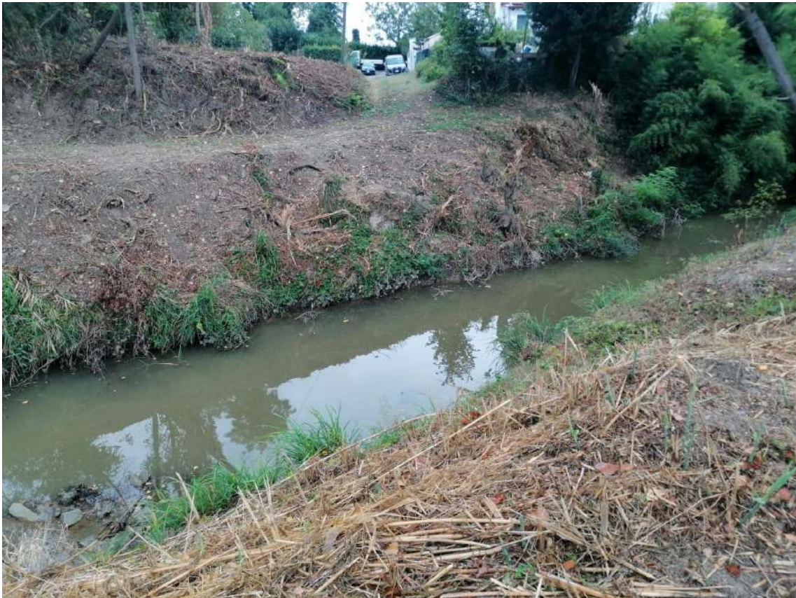
Figura 7 – Sponde e letto del torrente Ausa. Foto scattata dalla sponda in sinistra idraulica.
