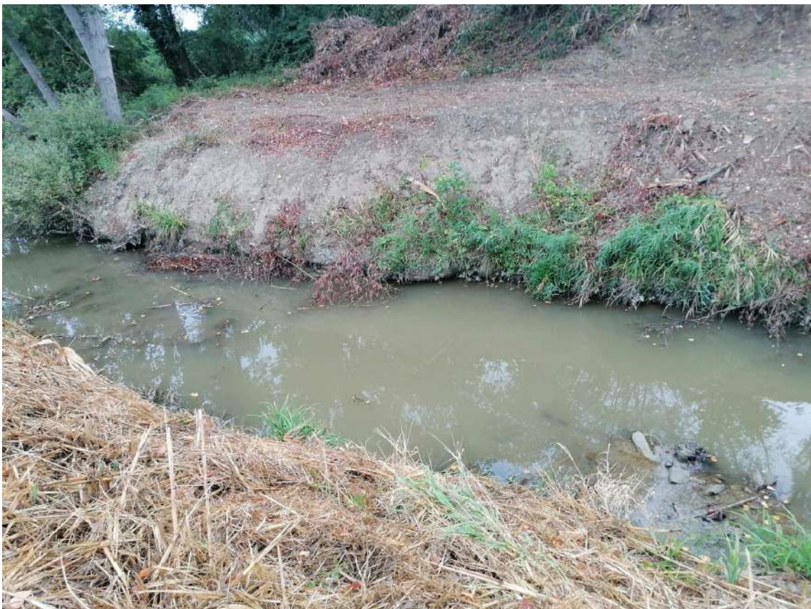
Figura 10 – Sponde e letto del torrente Ausa. Foto scattata dalla sponda in sinistra idraulica.
