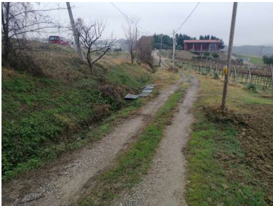
Figura 134 – Scarpata al piede della quale si prevede di realizzare a paratia in progetto.
