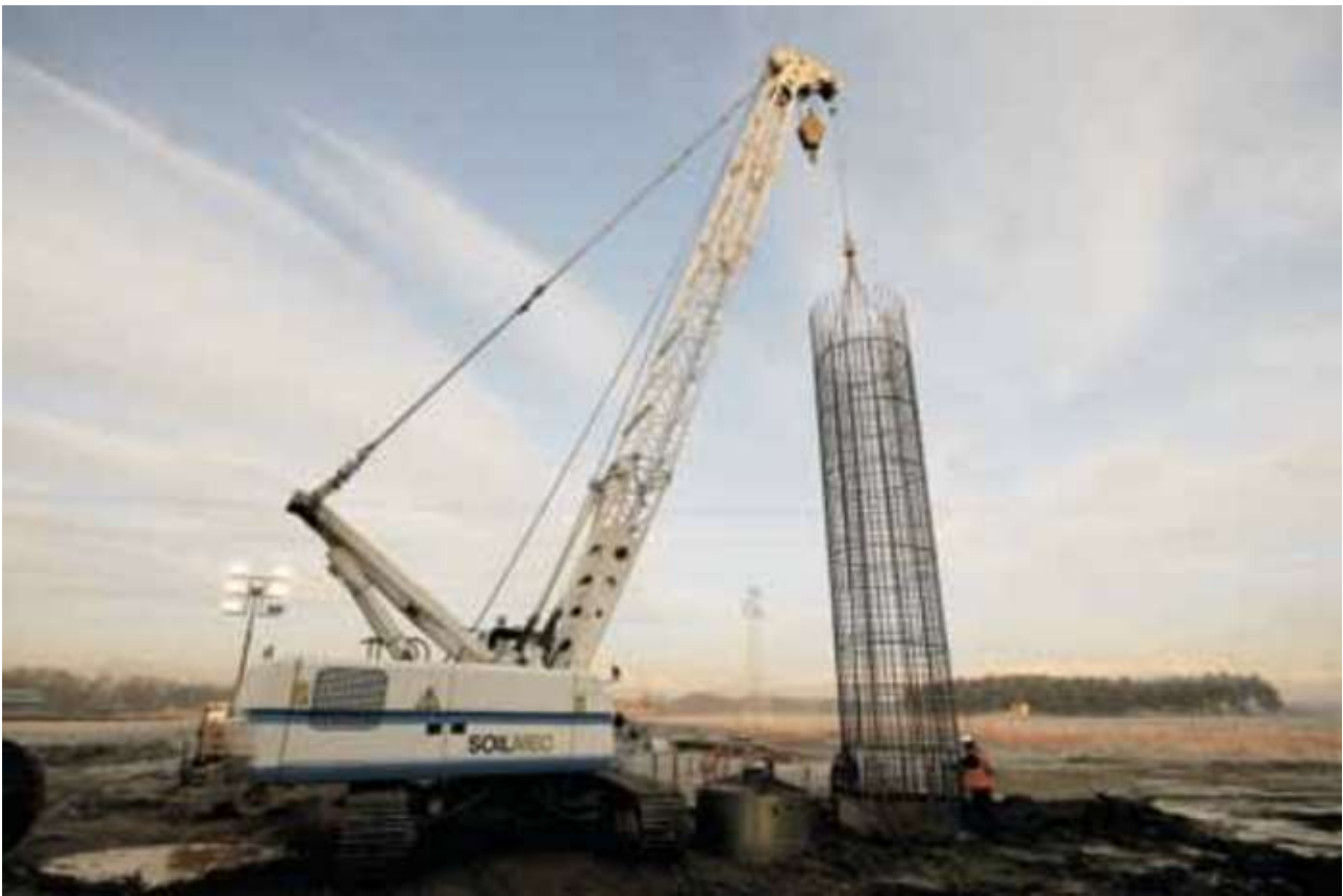
Figura 139 – Posa delle armature di un palo (fonte: TREVI S.p.A.).
