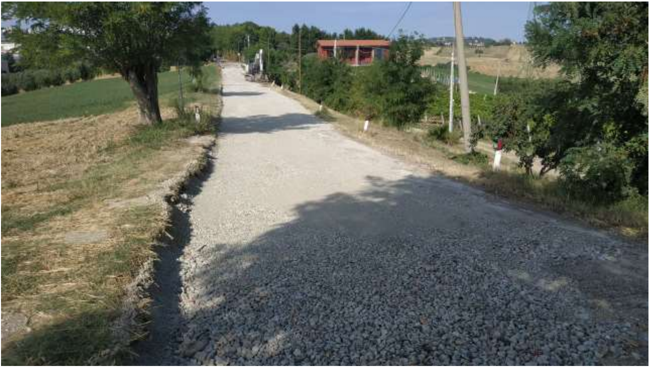
Figura 10 – Stato del tratto stradale in oggetto durante l'intervento di messa in sicurezza temporanea del luglio 2023 consistente nel ripristino della sovrastruttura stradale. A destra, il versante lato Nord. A sinistra, il versante lato Sud.
