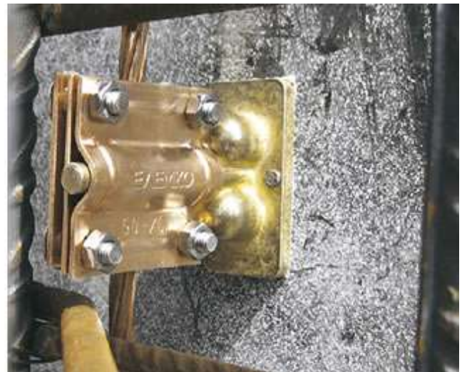
Figura 94 – Esempi di dispositivi di messa a terra delle armature di acciaio di elementi in c.a..
