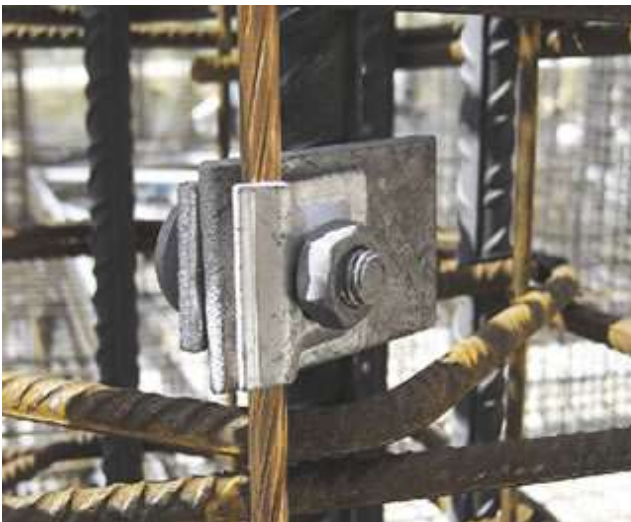
Figura 94 – Esempi di dispositivi di messa a terra delle armature di acciaio di elementi in c.a..
