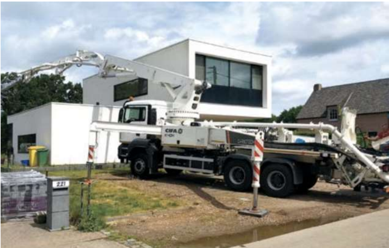
Figura 142 – Pompe autocarrate per getti di calcestruzzo.
