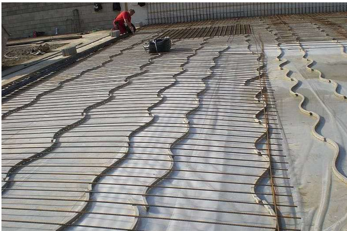
Figura 92 – Distanziatori in fibrocemento per armature orizzontali (fonte: Max Frank Italy S.r.l. - www.maxfrank.com ).
