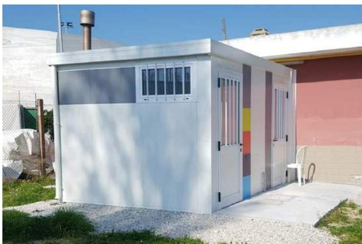
L'intervento è consistito nella realizzazione di due nuovi edifici prefabbricati, destinati uno a bagni per il pubblico e l'altro a spogliatoi istruttori e deposito, oltre alla ristrutturazione dell'edificio destinato a spogliatoi atleti per l'adeguamento alla normativa CONI realizzando bagni e docce accessibili ai diversamente abili.
