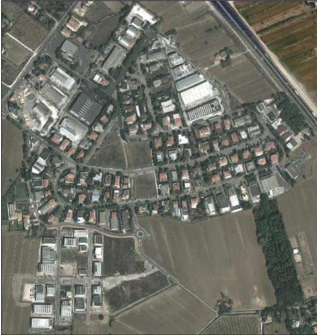
Figura 9.13: Zona Industriale Villaggio I° Maggio
