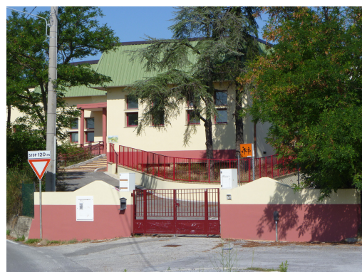
Scuola materna ed elementare Montecieco
