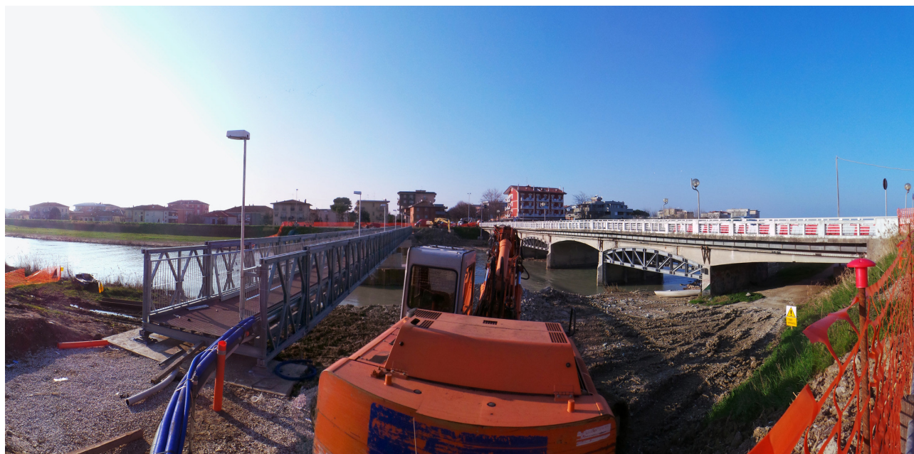
Ponte ciclopedonale via Coletti
