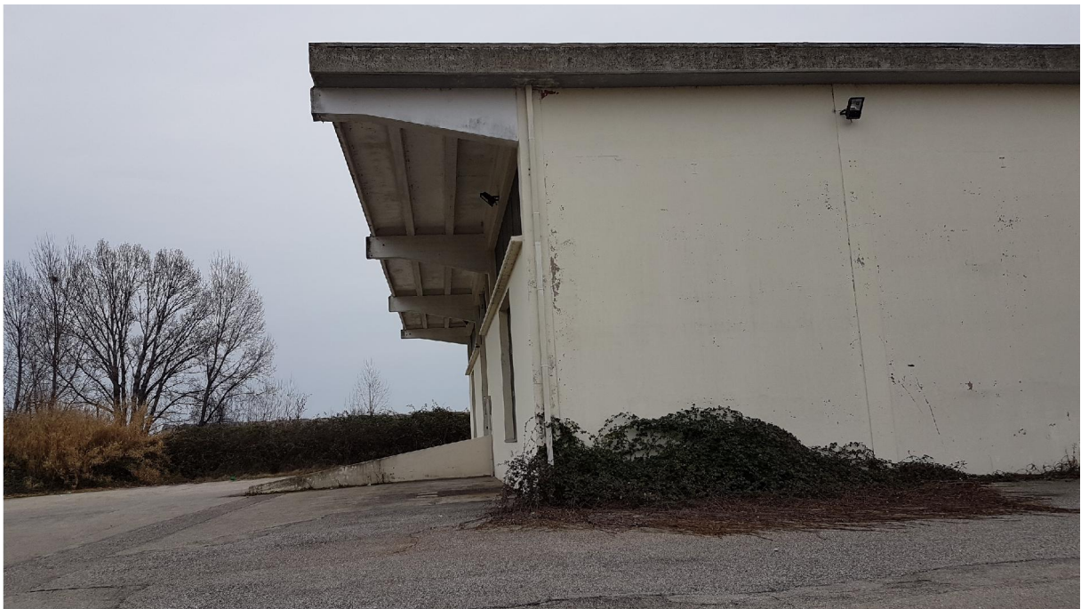
Il retro del capannone
