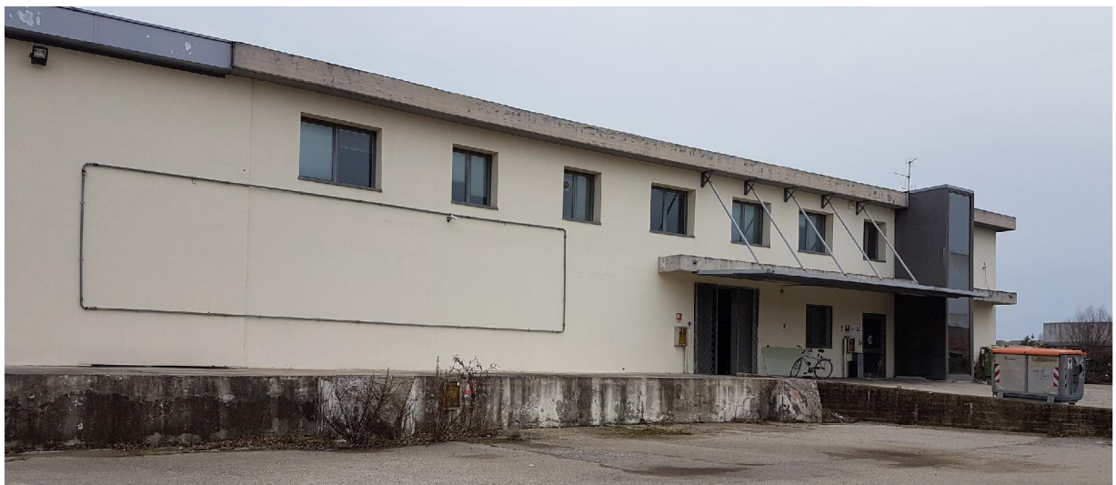
Il fabbricato visto dall'esterno, fronte sulla via Emilia: notare il piano di carico e scarico dei camion e (a destra) l'ascensore per gli uffici
