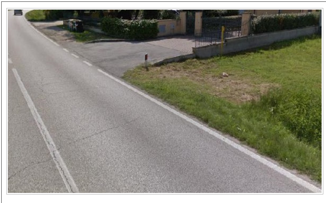
Fig. 27 – Esempio di tombinamento del fosso stradale con adeguato raccordo alla carreggiata e arretramento del sistema di chiusura con idonea area di stazionamento pavimentata.
