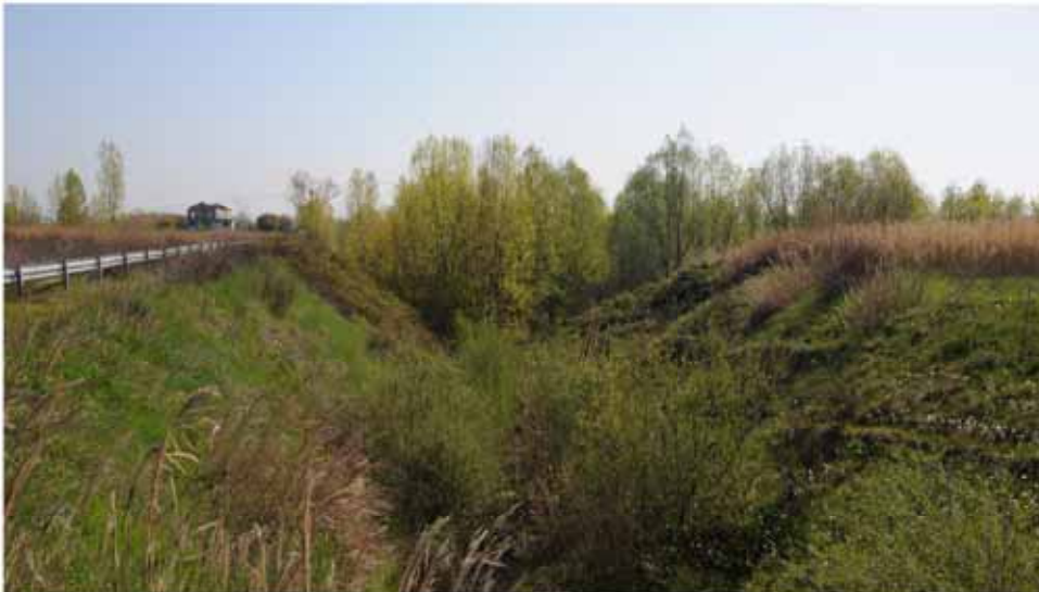
V11 - fosso scolmatore
