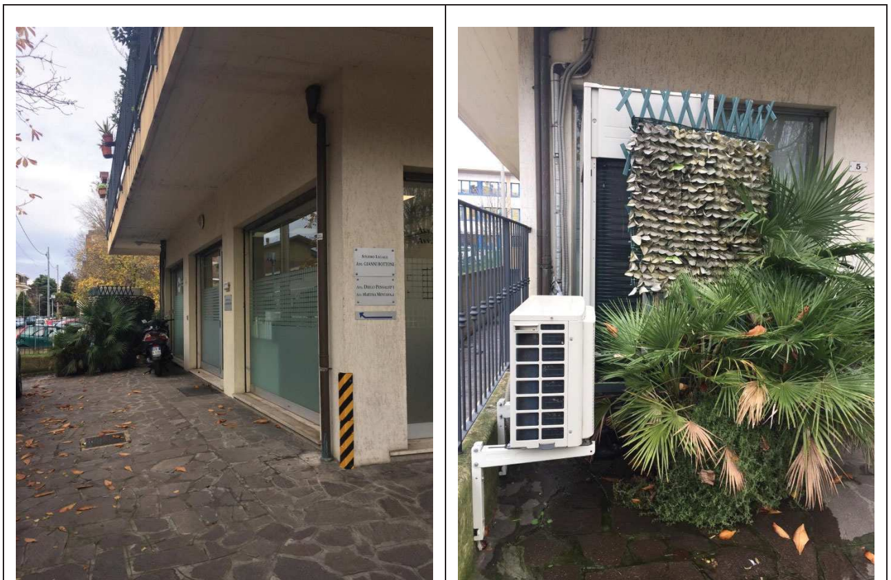
Figura 8 Impianti in prossimità di P2
