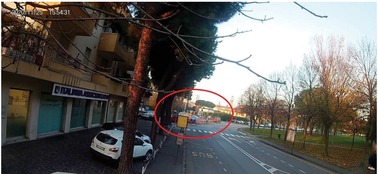
Figura 7 Cantiere in prossimità di P2
