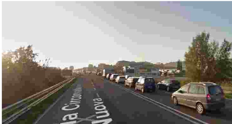
Figura 18: congestione lungo la SS16 in prossimità dell'intersezione con via Covignano
